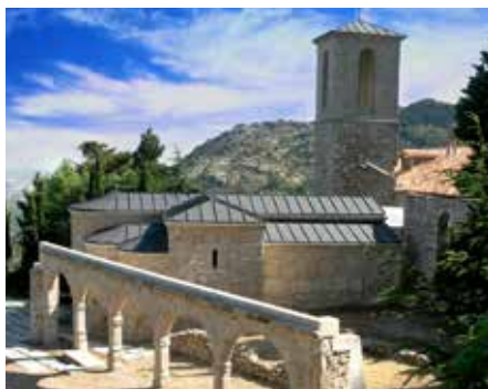
Convento San Antonio, La Cabrera
